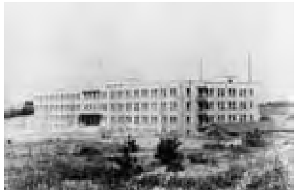
写真1：完成間近の工学部旧1号館
