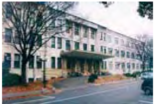
写真2：取り壊し前の工学部旧1号館（2001年）
