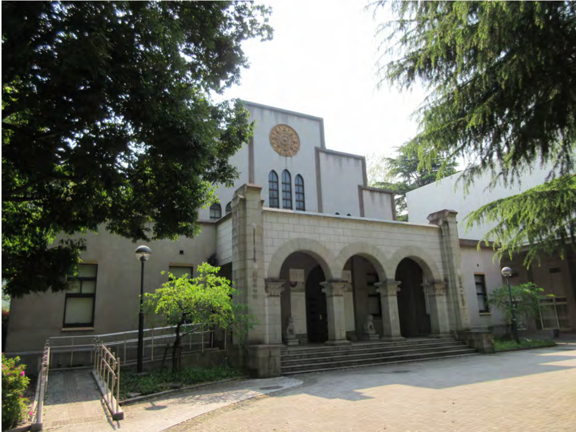
書庫及閲覧室（後の図書館、現駒場博物館）。正門と本館（現1号館）を結ぶ南北の線に対して、講堂（900番教室）と対称の位置にある。
