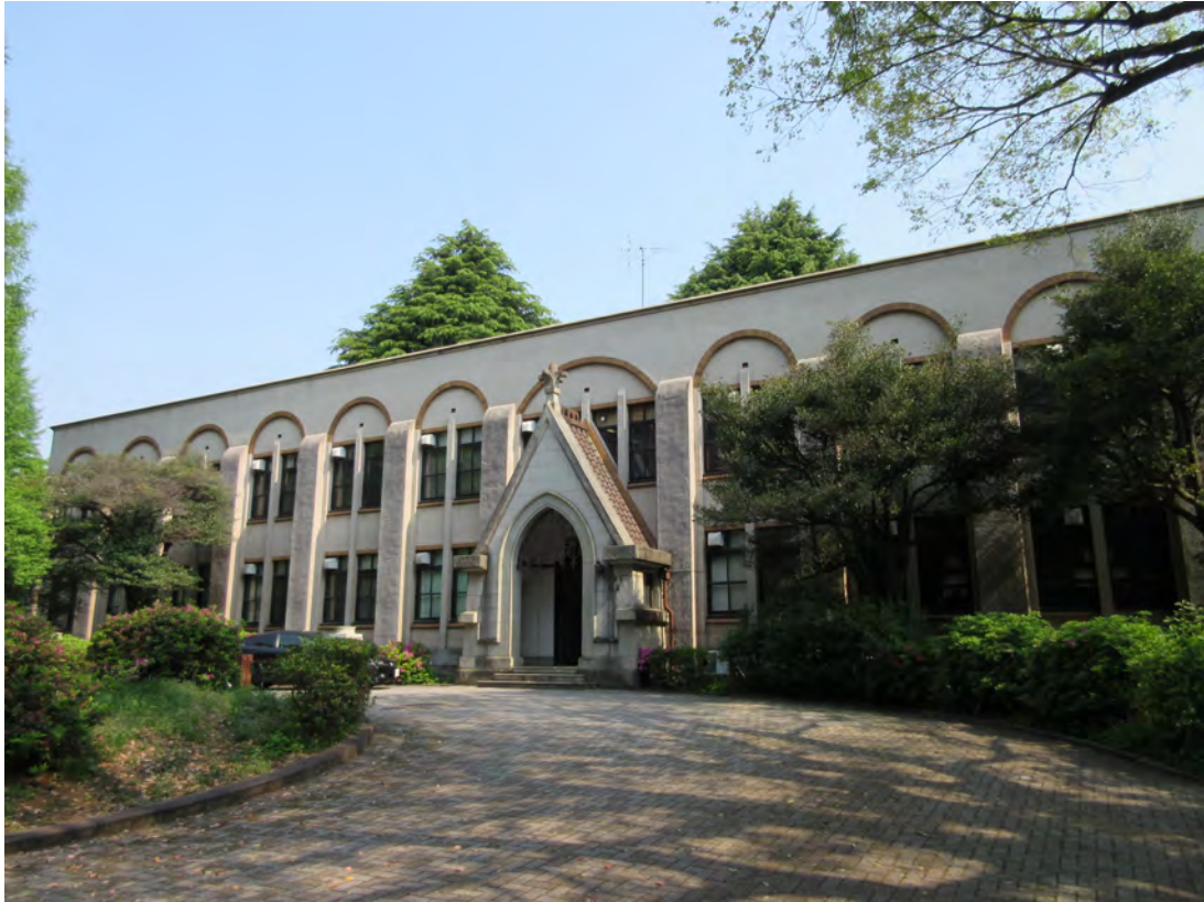
本館（現 1 号館）の東隣の特設高等科教室（現 101 号館）。
